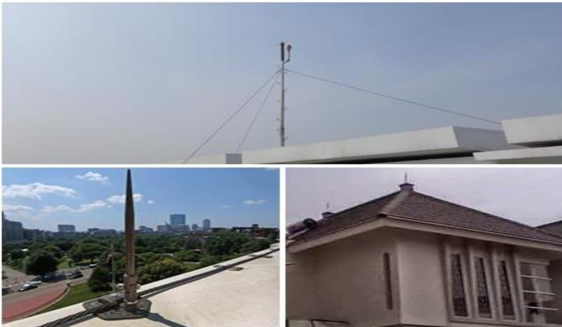
**Gambar 1.44** : Atap dengan Penangkal Petir
