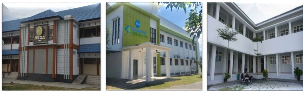
Gambar 5. Gedung Asrama, Aula dan Ruang Kelas
